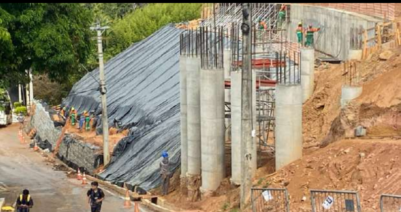
OBRA DO TALUDE CT
